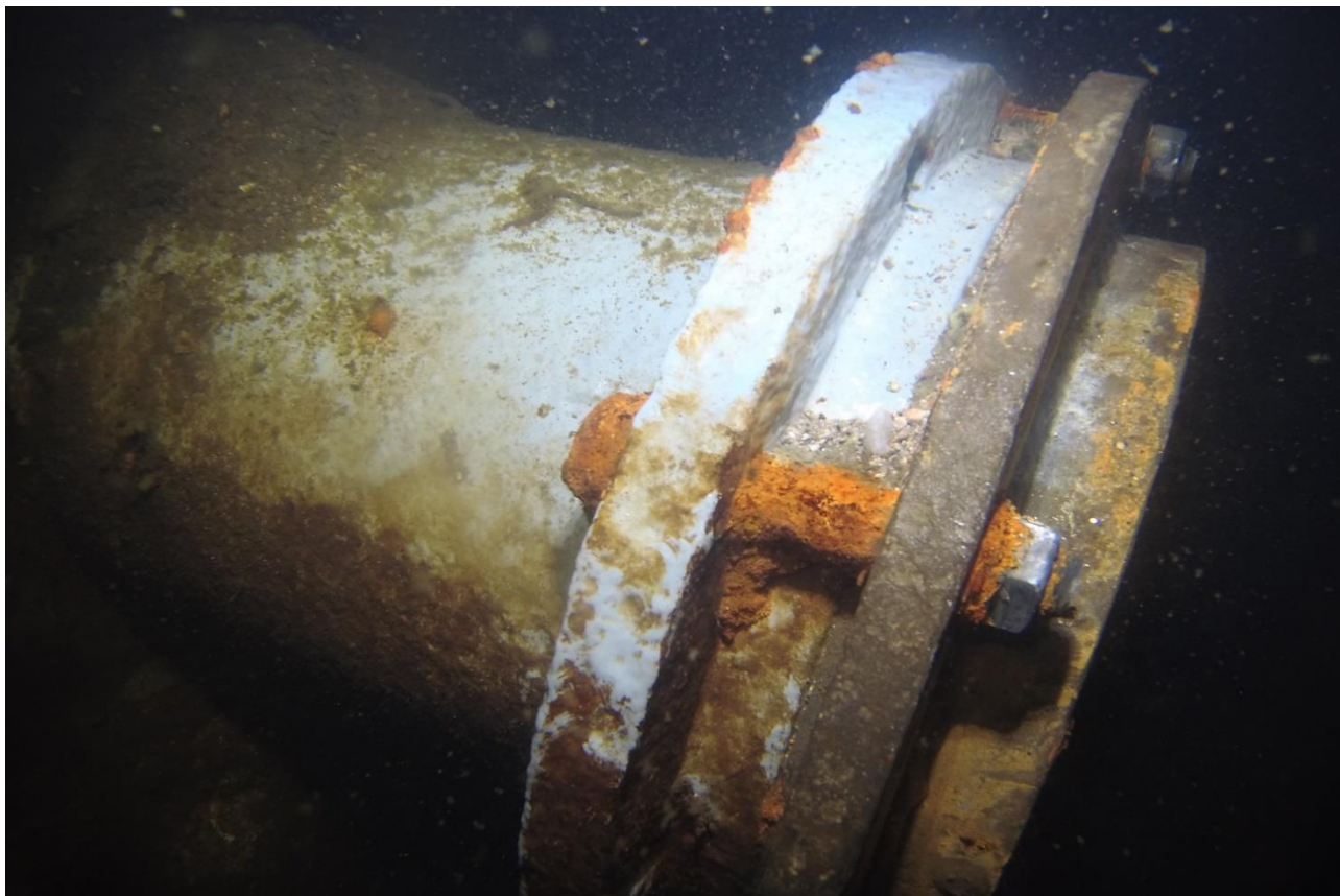
Foto PS, a.s.: Šroubové spoje vodárenských odběrů
