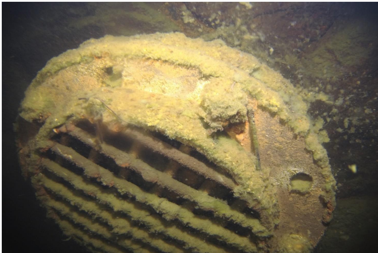
Foto PS, a.s.: Vodárenský odběr před očištěním
