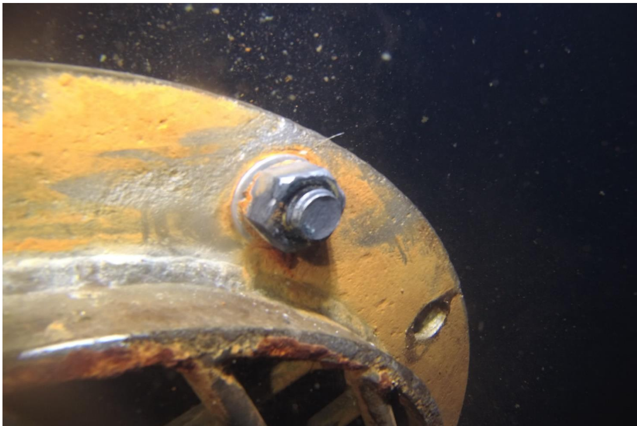
Foto PS, a.s.: Šroubový spoj po očištění
