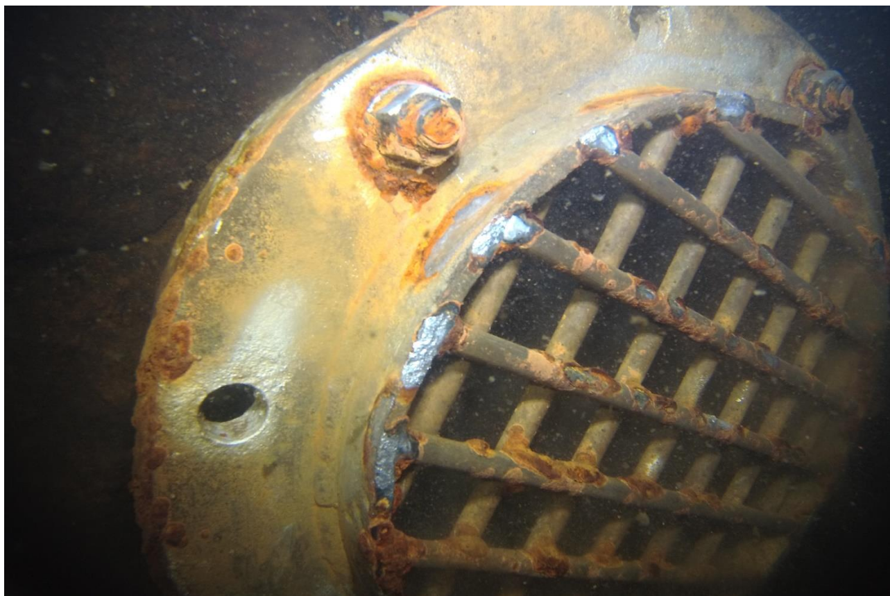
Foto PS, a.s.: Vodárenský odběr po očištění
