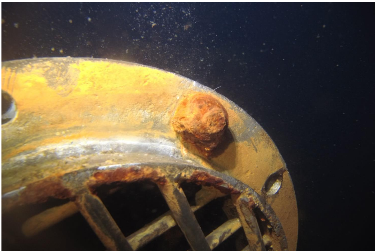
Foto PS, a.s.: Šroubový spoj VO před očištěním
